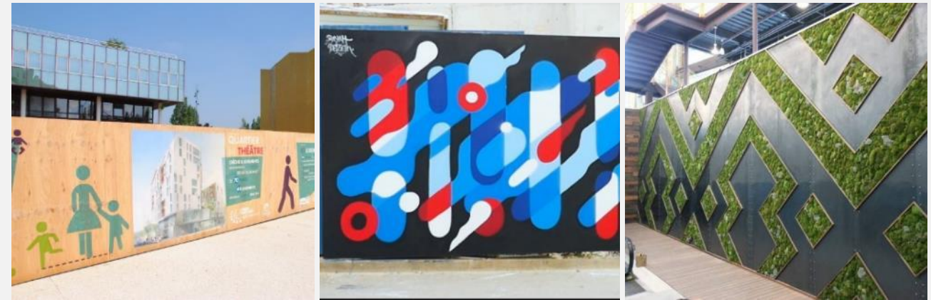
Figure 228 : Exemple de palissade de chantier, à gauche en bois avec un habillage pour l'information du public, au centre en lame avec illustration Street Art, à droite avec végétalisation
