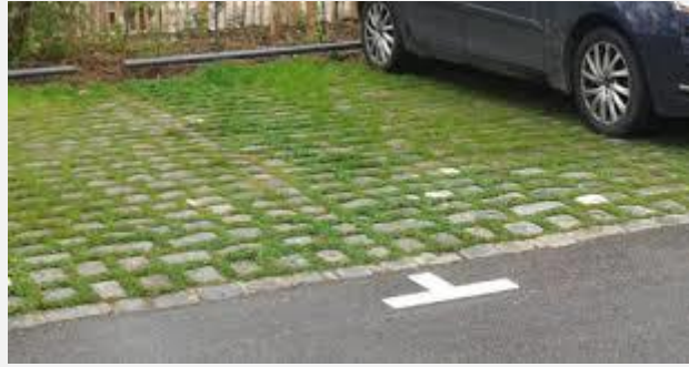
Exemple de parking infiltrant
